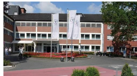
Abb. 42: St. Marien-Hospital (Quelle: smh-luedinghausen.de o.J.)
