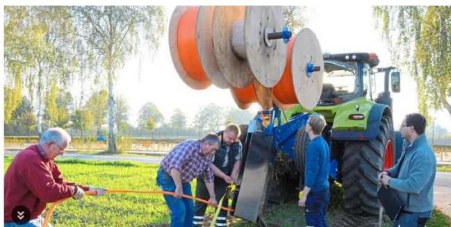
Abb. 65: Glasfaserausbau durch „Buddelvereine“ (Quelle: Westfälische Nachrichten 2019 )
